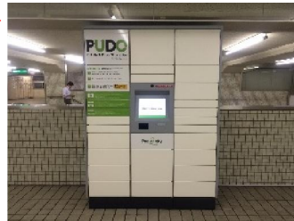
▲京阪守口市駅構内に設置(正面)
